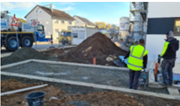
(Réalisation des fondations du module et des connections hydrauliques)
